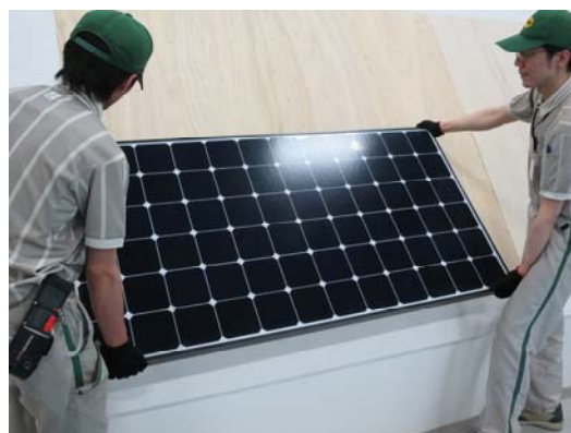
太陽光パネルの設置
